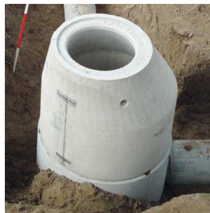
Door de verschillende standaardhoogtes en toepassing van 1 enkele verbinding kunnen inbouwhoogtes van 4 meter worden behaald.
